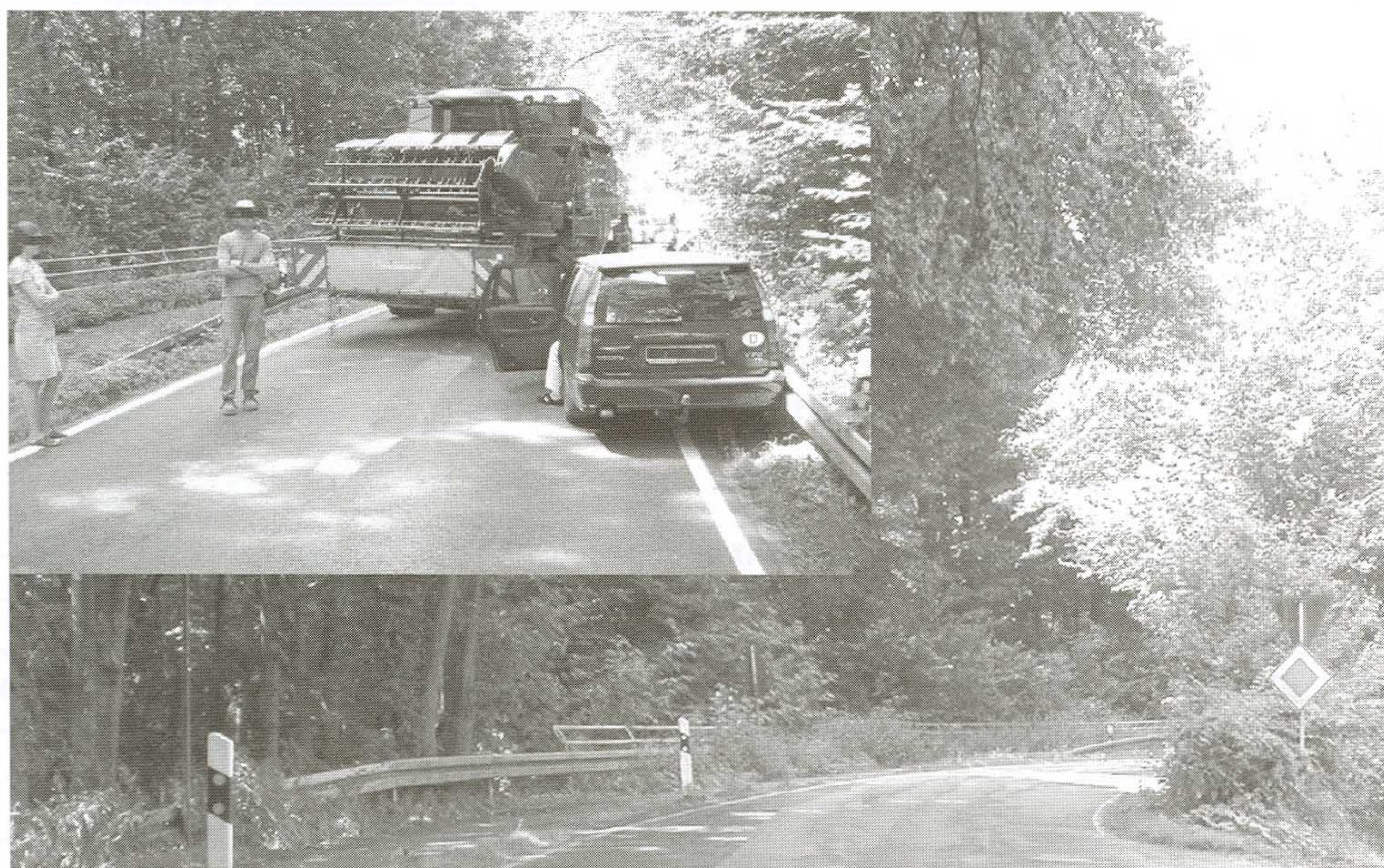
Abb. 4: Sichtbehinderung durch Bewuchs
